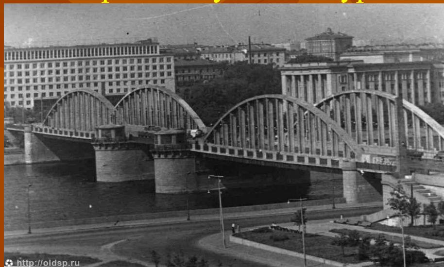
**Был построен арочный ЖД мост через реку Исеть пролетом 140 м из двух трубобетонных поясов из труб 820x13 мм из Ст 3, заполненных бетоном М 350. Стойки тоже трубобетонные.**
